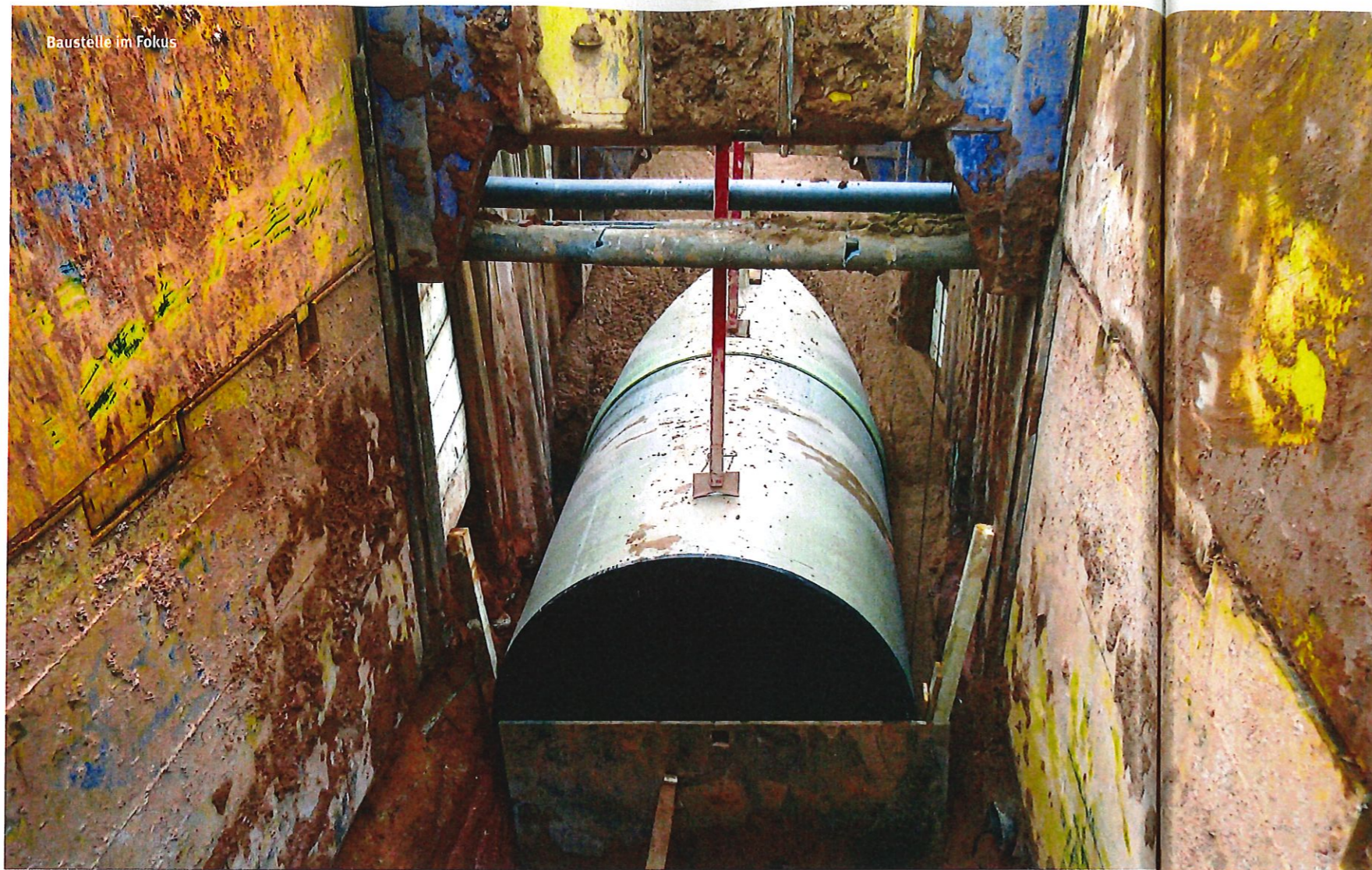
Der Flüssigboden wird in den Rohrgraben eingebracht.
