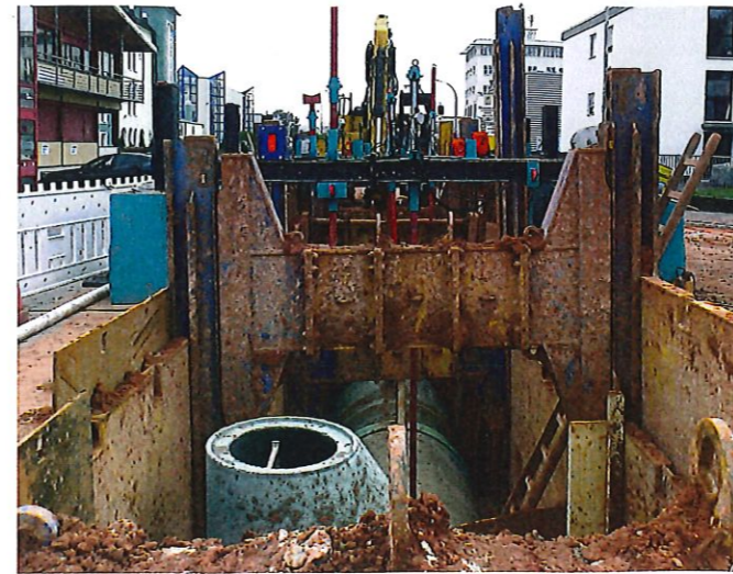
Der SBH-Gleitschienenverbau ist optimal auf den Flüssigbodeneinbau abgestimmt.
