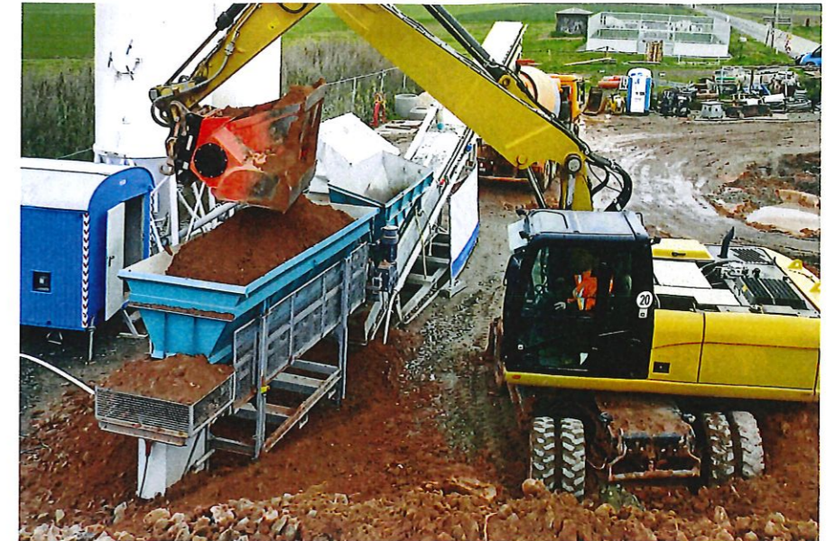
In der Aufbereitungsanlage wird der Aushub für den Flüssigboden vorbereitet.
